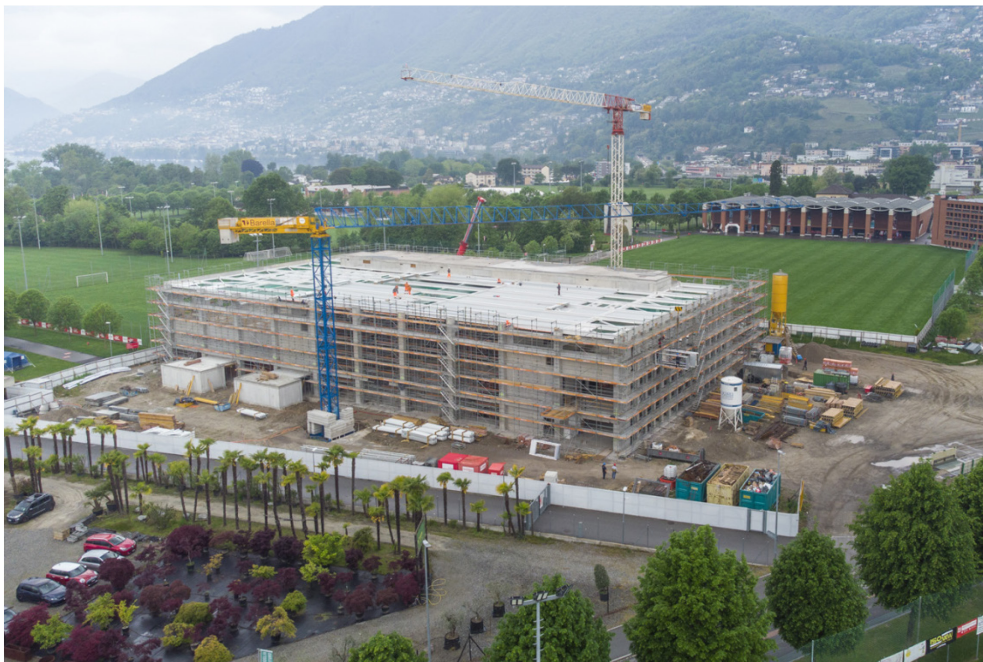
Abb. 8: Die Arbeiten im Zuge der vierten Bauetappe des CST schreiten zügig voran. Das Foto wurde am 10. Mai 2021 aufgenommen (Foto: Ti-Press).
